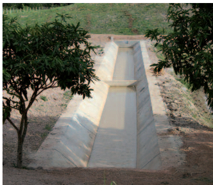
Verbesserung des Bewässerungssystems
